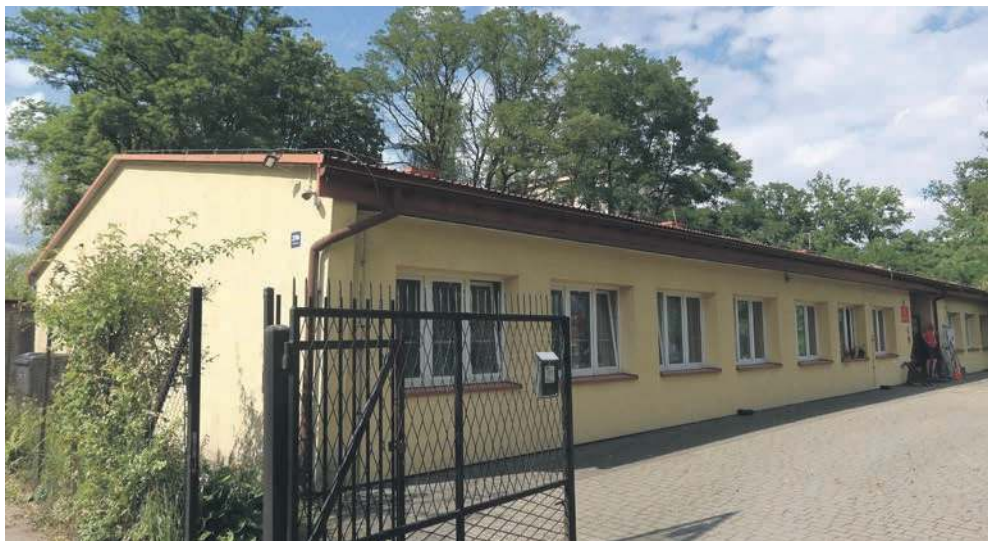
Budynek znajduje się w pobliżu dawnego stadionu Fabloku
