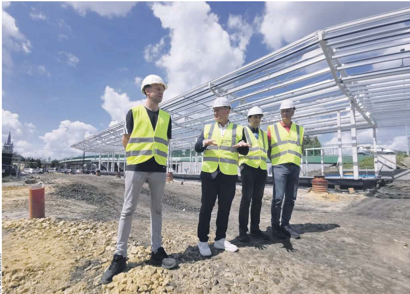
Opowiadający za realizację prac ze strony wykonawcy Maciej Nowak, burmistrz Jarosław Okoczek, inspektor nadzoru z ramienia gminy Edward Partyka i dyrektor wydziału geodezji i gospodarki nieruchomości w trzebińskim urzędzie Paweł Korbiel
