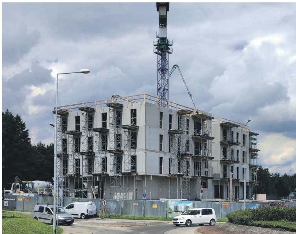
Budowa bloku w ramach Społecznych Inicjatyw Mieszkaniowych na osiedlu Północ w Chrzanowie
