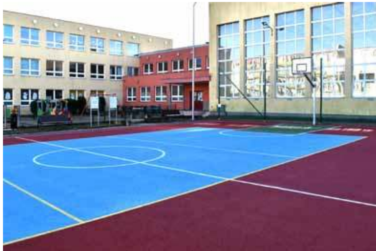
Jedną z realizacji w ramach SBO to m.in. boisko przy SP nr 11
