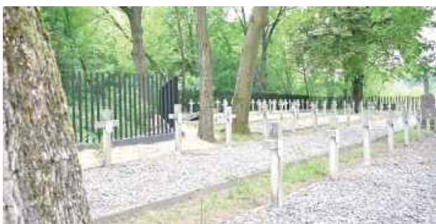
Wykonano nowe ogrodzenie o długości około 470 metrów wraz z solidną podmurówką
