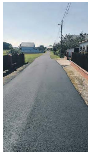
Nowa droga w Ćwierci
