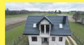
Dom w stanie surowym otwartym, Wólka Siemieńska, 885 851 160
