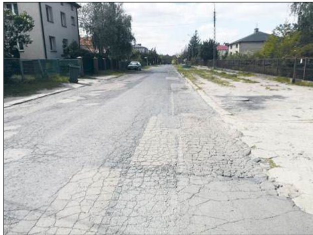
Ulica Twarda, wybudowana w latach 80-tych, pozostaje taka do dziś
