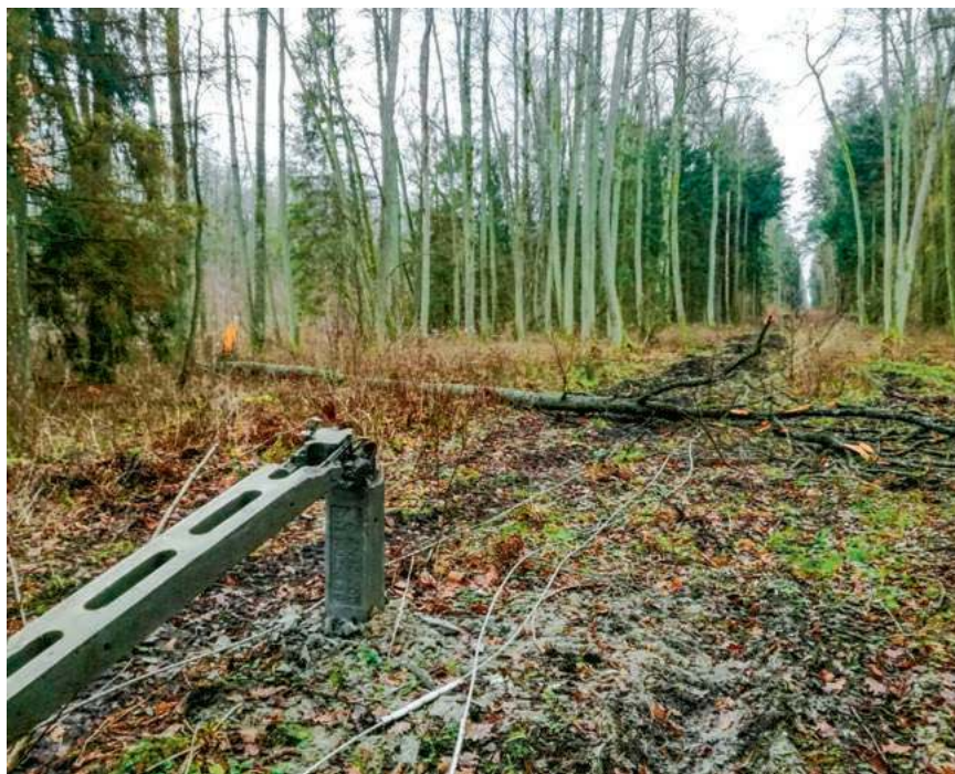
Linia energetyczna w okolicach Gnilca. Padające drzewa zrywały ją od wielu lat, grudzień 2019 r.
