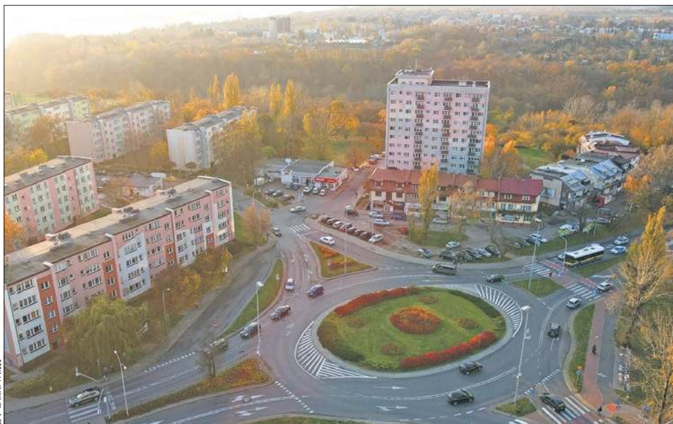
Osiedle Skarpa. Na przyszły rok zaplanowano remont ulicy Na Skarpie, która prowadzi do widocznego na zdjęciu ronda Grabskich
