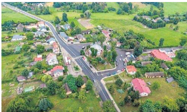
Nowa nawierzchnia, wyremontowany chodnik i bezpieczniejsze przejście dla pieszych
