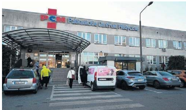
Inwestycja ze środków unijnych ma być zakończona do końca przyszłego roku
