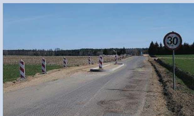
Droga Żurominek–Stupsk w przebudowie s. 3
