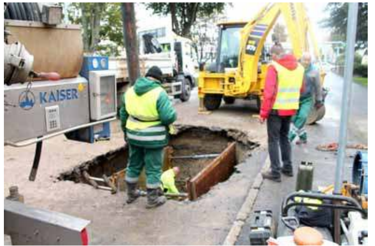
Prace naprawcze trwały od godziny 15 a zasypowe do wieczora
