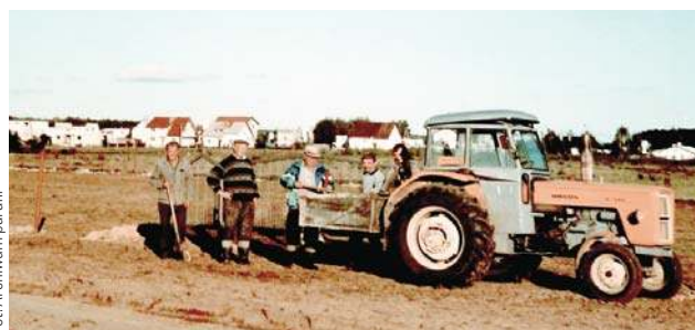
Chwile przed rozpoczęciem budowy kościoła w Jamielniku
