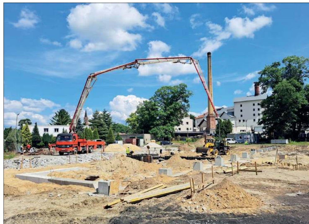
■ Budowa lodowiska na terenie OSiR w Raciborzu postępuje. Włodarz miasta zapowiada, że obiekt będzie gotowy w ferie zimowe 2024.
