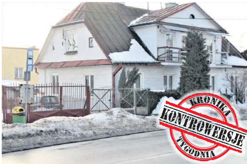
Kłopotliwy przystanek przy ul. Żdanowskiej w Zamościu.
