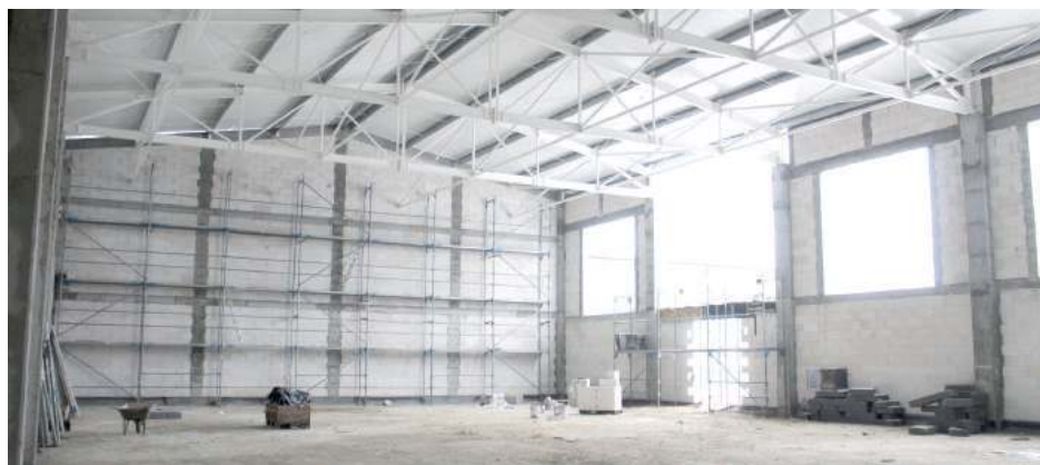
Obie hale, które powstają w gminie Kąkolewnica, zostaną oddane do użytku w połowie 2024 roku
