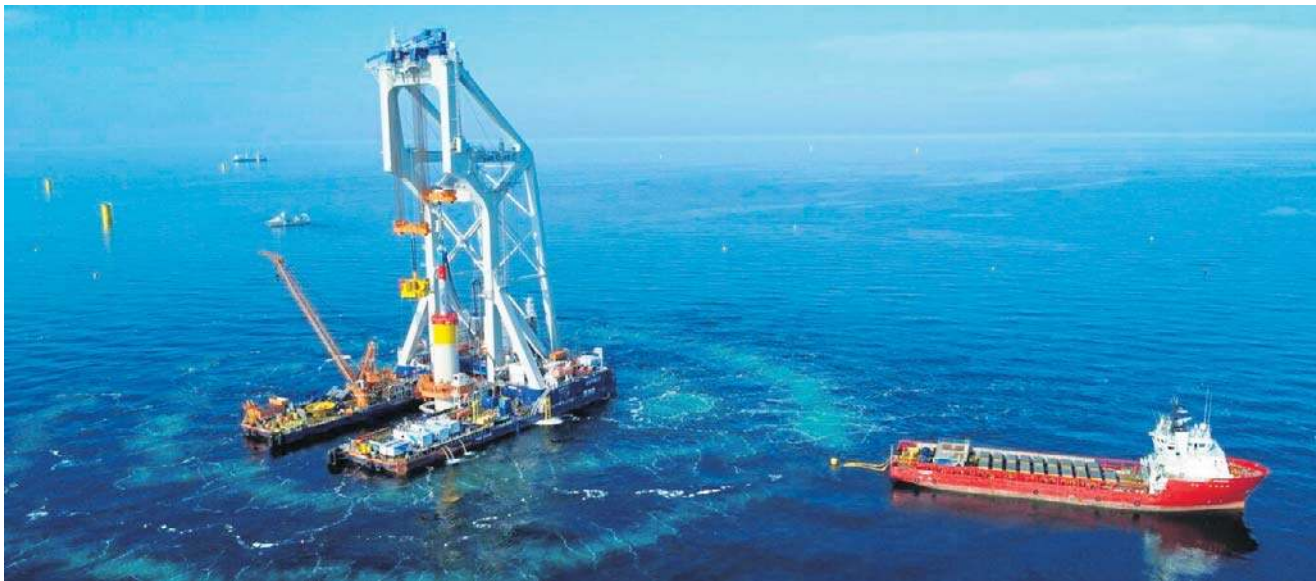
Instalacja monopali na Morskiej Farmie Wiatrowej Baltic Power
