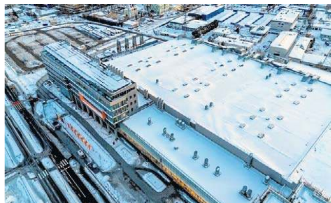
Jak poinformowali administratorzy profilu Amberexpo, dach hal MTG był odśnieżany od 13 do 16 stycznia
