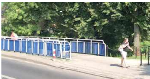
Na ul. Warszawskiej na Krznie zbudowano w ciągu drogi krajowej wygodną kładkę
