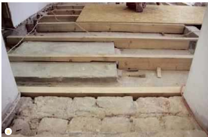
🔧 Przejście z korytarza do pokoju po rozpoczęciu odbudowy konstrukcji podłogi (a) i to samo miejsce na krótko przed ukończeniem prac przy posadzkach (b). W pokoju nowy dębowy parkiet, w korytarzu gresowe płytki. J. WERNER
