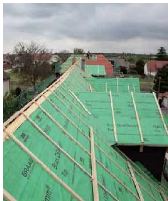
🔧 Współcześnie za szczelność dachu odpowiada także podkład, czyli np. układana pod pokryciem folia wysokoparoprzepuszczalna. BMI BRAAS
