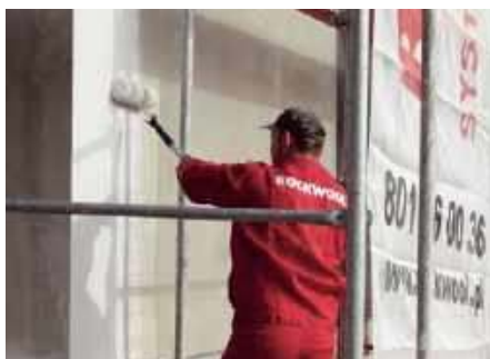
7 Gruntowanie ścian.
