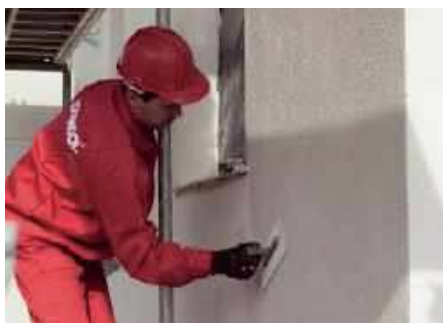
8 Tynkowanie. ROCKWOOL
