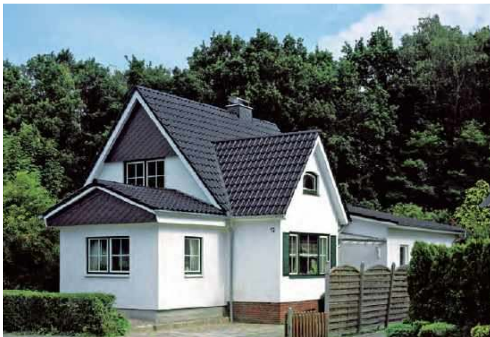
Nowe pokrycie z dachówki przeżyje kilka pokoleń właścicieli tego domku. CREATON POLSKA
