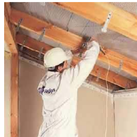
Tylko zdrowe i suche drewno można bez obaw zakryć izolacją i zabudować. RIGIPS
