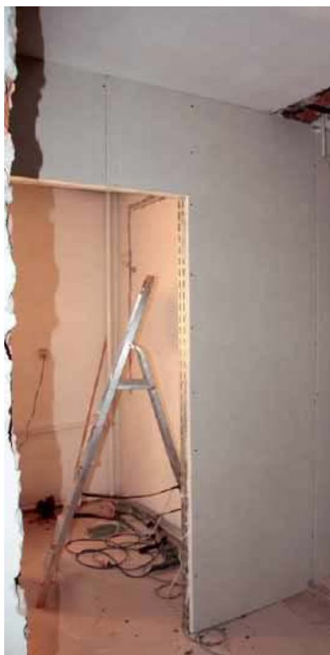
🔧 Krawędzie otworu, w którym zostaną osadzone drzwi, wzmacnia się profilami ościeżnicowymi UA. J. WERNER
