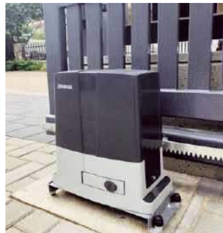
➊ Przesuwne bramy z napędem zwykle wyposażone są w siłownik w postaci niewielkiej skrzynki. BENINCA
