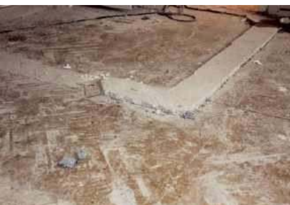
📍 Spodnie warstwy podłogi widoczne po zdjęciu posadzki – płyty drewnopochodne na legarach i resztki dawnej ścianki działowej. J. WERNER
