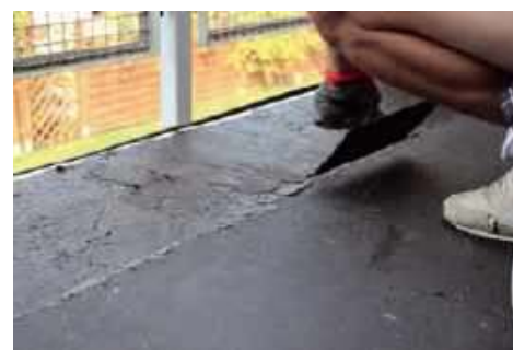
🔪 Trzeba bardzo starannie przygotować podłoże pod nowe płytki. Nie zapominajmy o izolacji. J. WERNER
