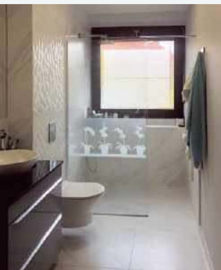
Wannę zastąpiono obszerną kabiną prysznicową typu walk-in, założono wodną podłogówkę.
