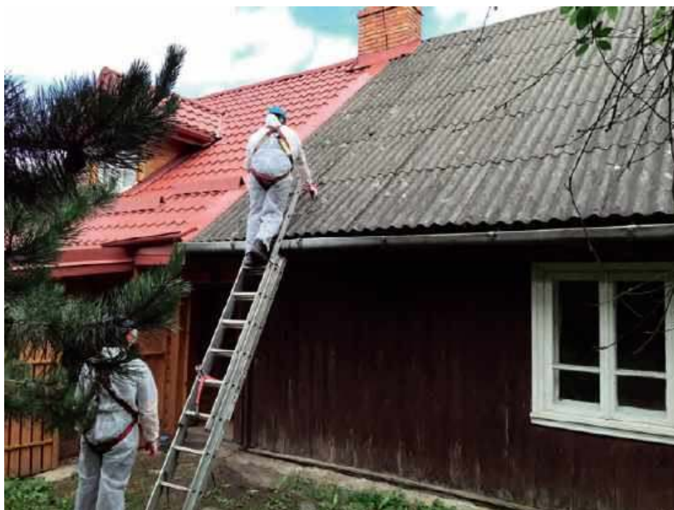
🔧 Pokrycia z eternitu mogą demontować tylko firmy dysponujące odpowiednim zezwoleniem. P. KONIKOWSKI
