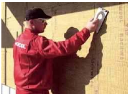
2 Szlifowanie powierzchni płyt.
