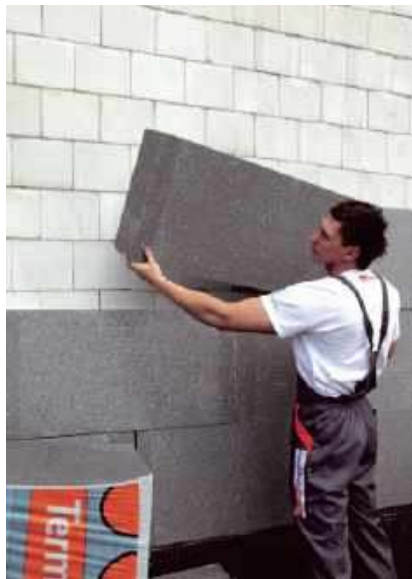
● Szary styropian coraz częściej zastępuje standardowy biały, choć podczas prac wymaga bezwzględnie ostonienia ścian przed działaniem słońca. TERMO ORGANIKA
