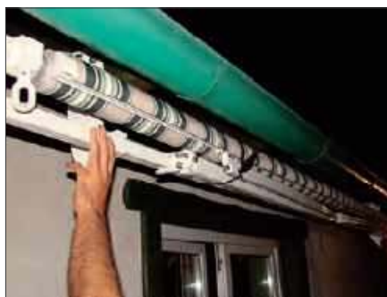
5 Umieszczenie w wieszakach kasety lub listwy startowej markizy.
