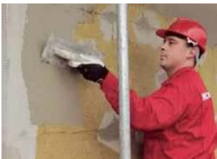
5 Nakładanie zaprawy zbrojącej.
