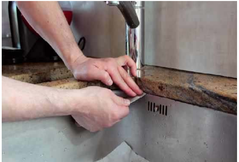
❗ Stary silikon usuwamy przy pomocy noża. Tu uszczelnia połączenie stalowego zlewozmywaka i blatu z kamienia, które trudniej uszkodzić czy porysować niż np. akrylowy brodzik. A. WERNER
