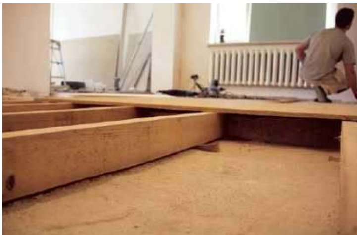
🔧 Na stropach żelbetonowych legary układa się bezpośrednio na płycie stropowej i poziomuje drewnianymi klinami. J. WERNER
