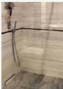
➋ W kabinie walk-in jest ścienny odpływ liniowy i podtynkowa bateria.
