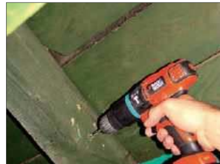
3 Wiercenie otworów w zaznaczonych miejscach.
