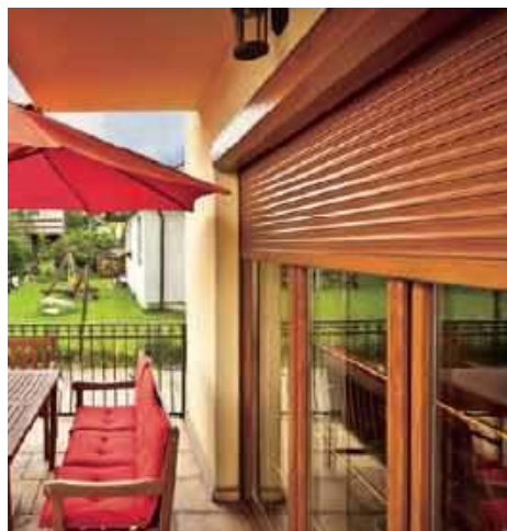
📌 Roleta naokienna, czyli przykręcana do ramy okna, zwijana lewoskrętnie. ANWIS
