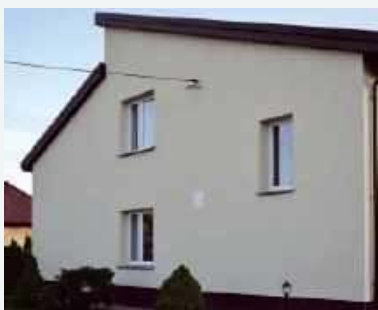
Nową elewację wykończono tynkiem silikonowym, marmolitem, stalowymi parapetami.
