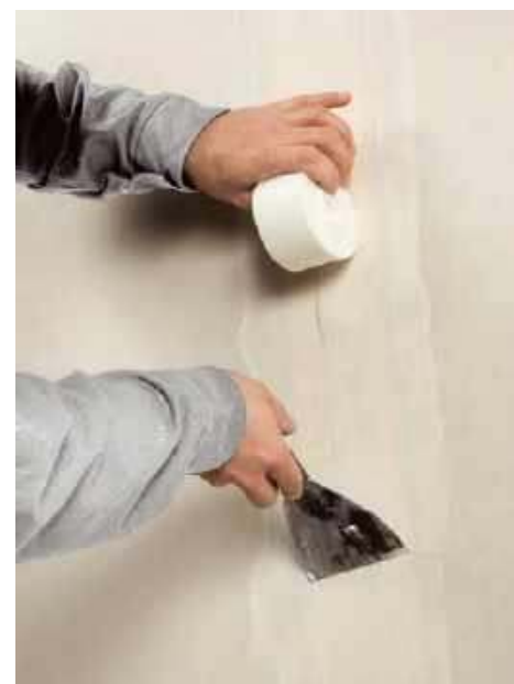
❷ Płyty gipsowo-kartonowe wymagają wykończenia miejsc połączeń poprzez wtopienie taśmy zbrojącej w masę szpachlową. J. WERNER, SINIAT, SINIAT
