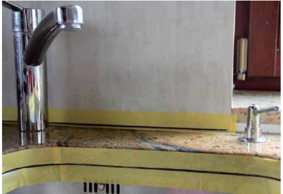
❗ Szczeliny przeznaczone do fugowania oklejone taśmą malarską, która zabezpiecza blat, zlew i płytki przed zabrudzeniem oraz umożliwia uzyskanie równej krawędzi fugi. J. WERNER
