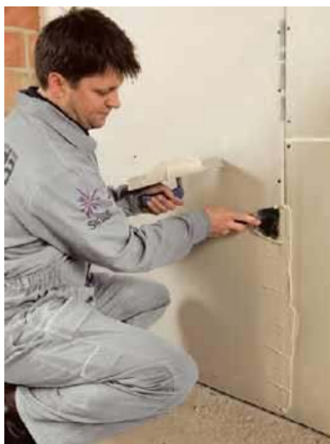
❷ Płyty gipsowo-kartonowe wymagają wykończenia miejsc połączeń poprzez wtopienie taśmy zbrojącej w masę szpachlową. J. WERNER, SINIAT, SINIAT
