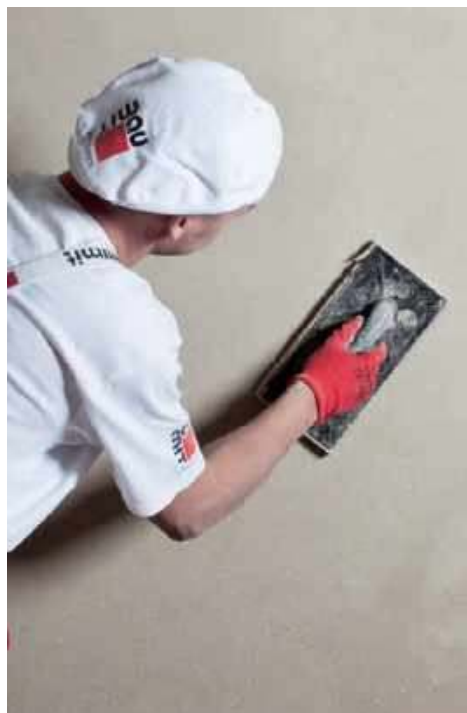
🔧 Wyrównywanie łatą wstępnie związanego tynku (a) oraz zacieranie końcowe (b). Prace tego typu należy prowadzić w temperaturze 5–25°C, unikając bezpośredniego nasłonecznienia i przeciągu. BAUMIT
