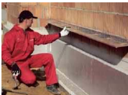
1 Montaż listy cokołowej i przyklejanie płyt wełny mineralnej.
