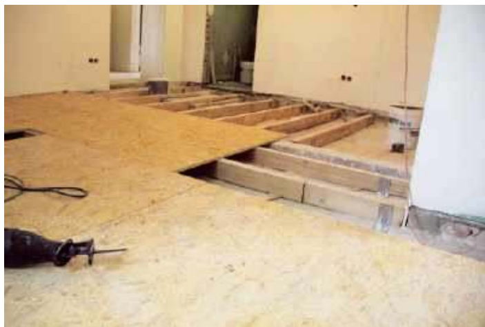
🔧 Po zamocowaniu legarów, wykonawcy rozłożyli płyty OSB „na próbę”, aby ograniczyć ich sztukowanie. J. WERNER
