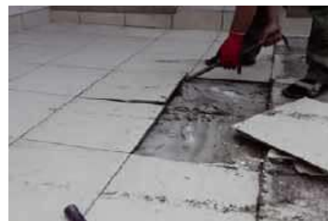
🔪 Stare płytki i klej zwykle łatwo jest usunąć. J. WERNER
