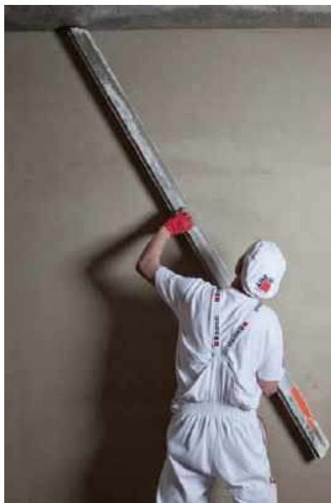
🔧 Wyrównywanie łatą wstępnie związanego tynku (a) oraz zacieranie końcowe (b). Prace tego typu należy prowadzić w temperaturze 5–25°C, unikając bezpośredniego nasłonecznienia i przeciągu. BAUMIT
