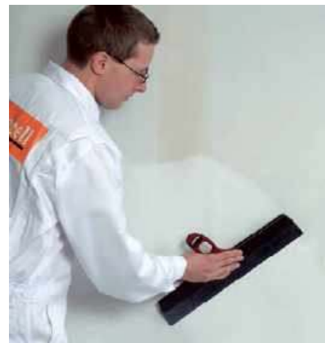
🔧 Podczas remontu, otynkowane ściany zwykle pokrywamy gładzią. Później je malujemy, ewentualnie wykańczamy tapetą. ATLAS, FERMACELL
