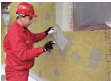
4 Osadzanie siatki wokół naroża okiennego.
