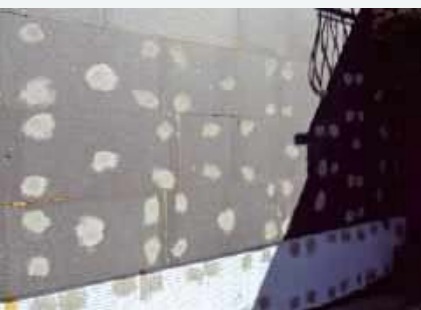
Na ławach fundamentowych i podmurówce ułożono styrodur o grubości 10 cm, a na ścianach – grafitowy styropian.
