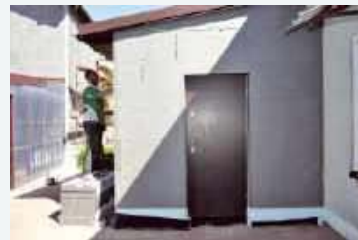
● Termomodernizację przeprowadzono również na zabudowaniach garażowych.
