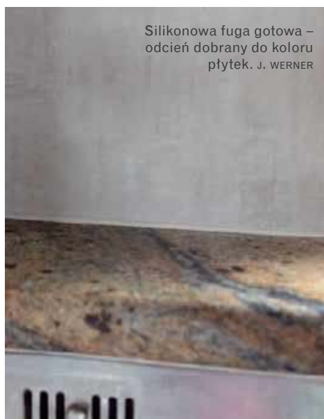
🔧 Nadmiar silikonu usuwa się specjalną szpachelką/kształtką (a SOPRO) albo – jak w tym przypadku – palcem mocznym w wodzie z dodatkiem mydła lub płynu do mycia naczyń (b A. WERNER).
