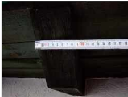
2 Dobranie długości wiertła z zależności od grubości krokwi.
