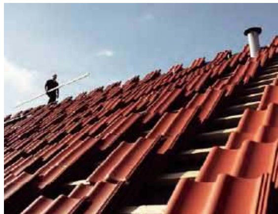
🔧 Jeśli nowa dachówka różni się od starej rozmiarem, konieczna jest zmiana rozstawu łąt. BMI BRAAS
