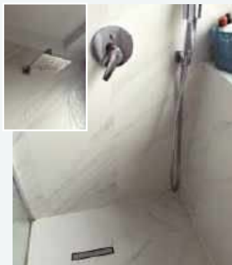
🔧 Odpływ liniowy o szerokości 30 cm, podtynkowa bateria i deszczownica.
