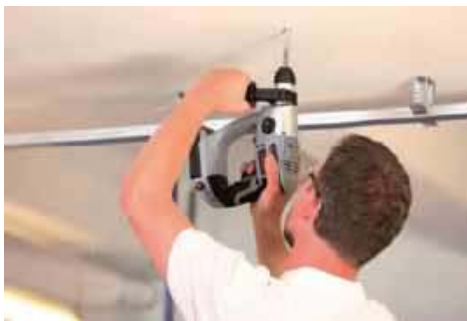
❗ Aby wiercić w betonie konstrukcyjnym, trzeba zaopatrzyć się w młotowiertarkę, która ma większą od zwykłej wiertarki moc i specjalny system mocowania wiertel. LANGE ŁUKASZUK (KRESS)
