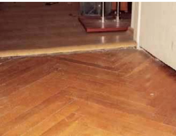
📍 Podłoga na parterze przed remontem – w pierwszym pomieszczeniu dębowy parkiet, w kolejnym ułożone później panele. J. WERNER
