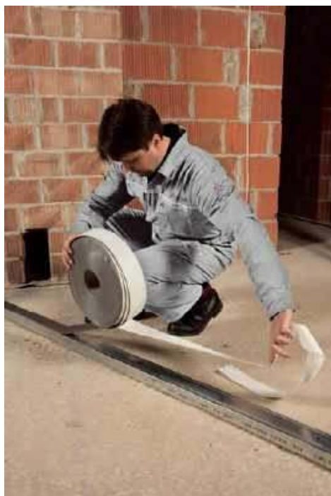
🔧 Profile obrysowe UW i CW podkleja się taśmą, która tłumi dźwięki i drgania. SINIAT
