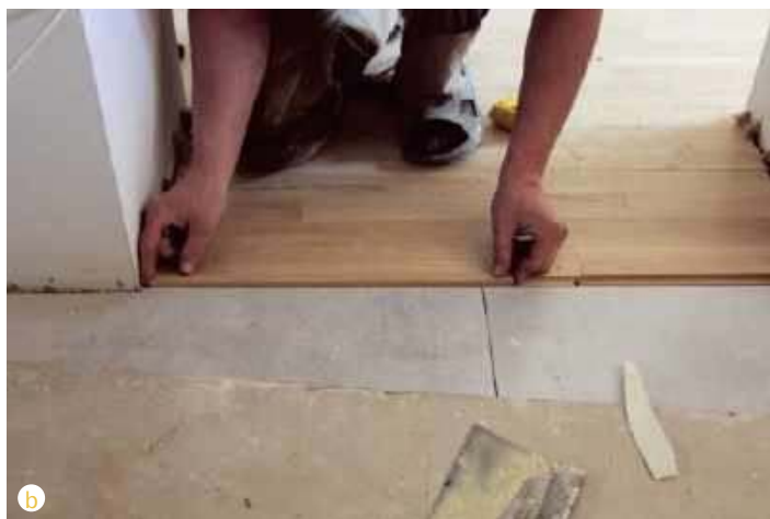
🔧 Przejście z korytarza do pokoju po rozpoczęciu odbudowy konstrukcji podłogi (a) i to samo miejsce na krótko przed ukończeniem prac przy posadzkach (b). W pokoju nowy dębowy parkiet, w korytarzu gresowe płytki. J. WERNER
