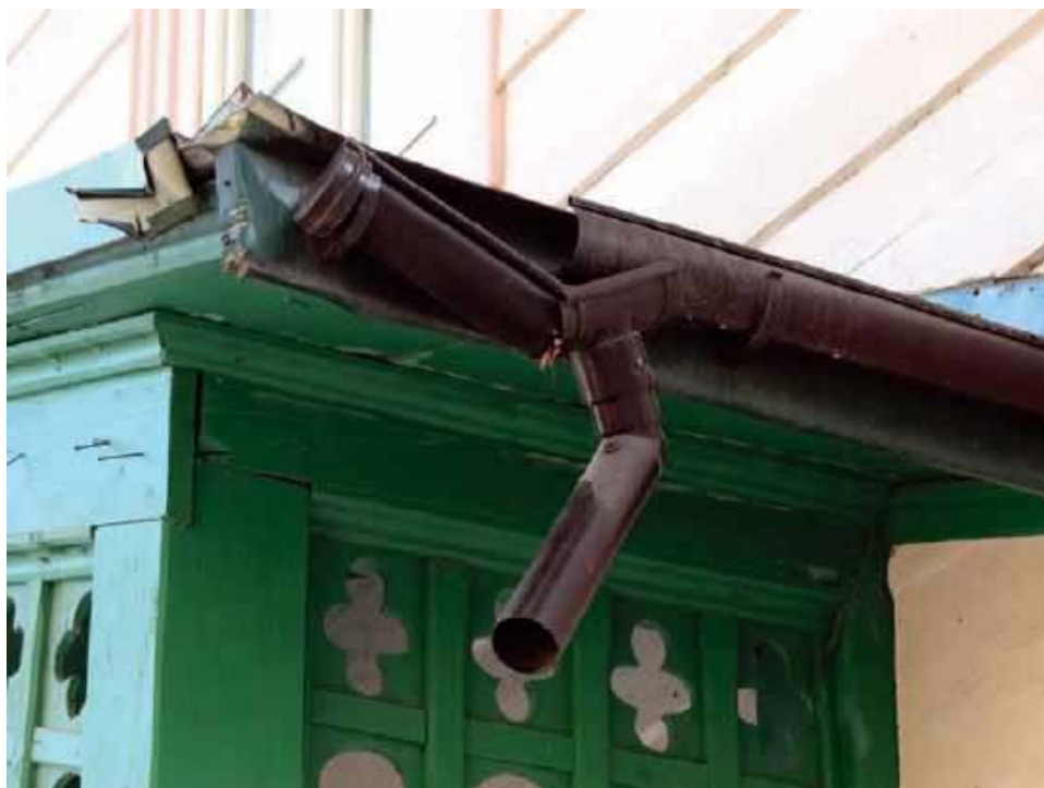
Remont dachu to najlepsza okazja do wymiany przedziewiałych i potamanych rynien. GALECO
