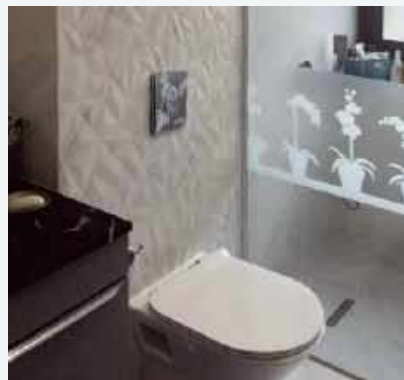
🔧 Ścianę za sedesem wykończono bezfugowymi płytkami 3D, imitującymi biały marmur (o wymiarach 30 x 120 cm).
