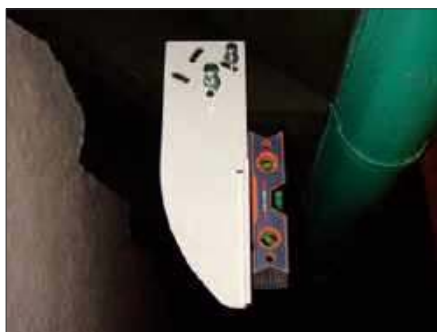
4 Przykręcenie wieszaków na kasety po uprzednim skorygowaniu ustawienia elementów.
