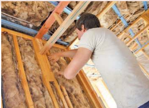
Dobre ocieplenie domu to podstawa, by żyło się w nim komfortowo.
