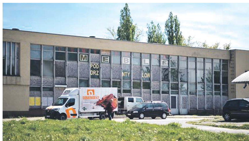
Zaniedbany Dworzec Północny w Lublinie
