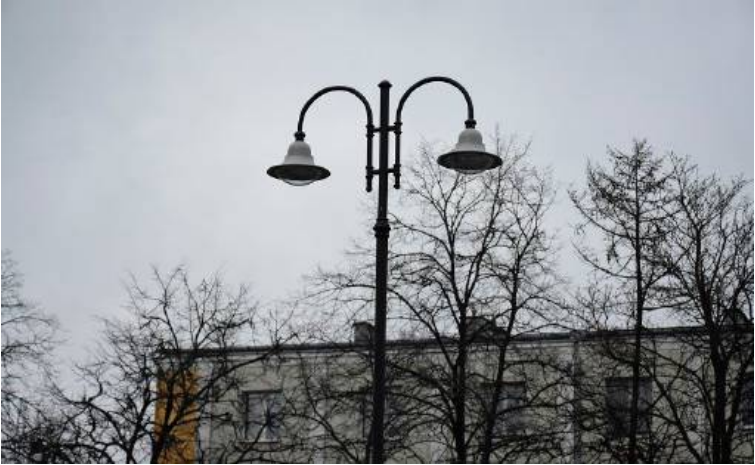
Miasto przeliczyło się sądząc, że podwyżkę cen prądu w znacznym stopniu zrekompenzuje przeprowadzona w ostatnich latach kompleksowa wymiana ulicznych latarni na energooszczędne lampy LEDowe
