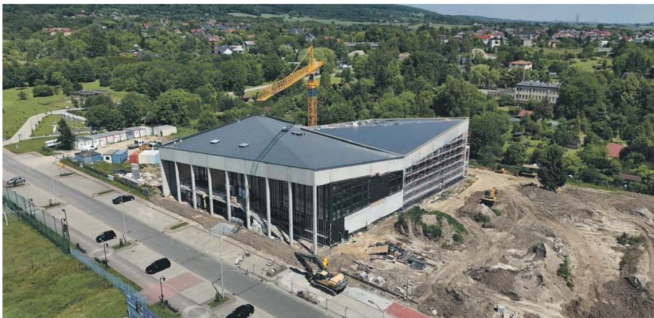
Tak obecnie wygląda powstający w Krzeszowicach basen
