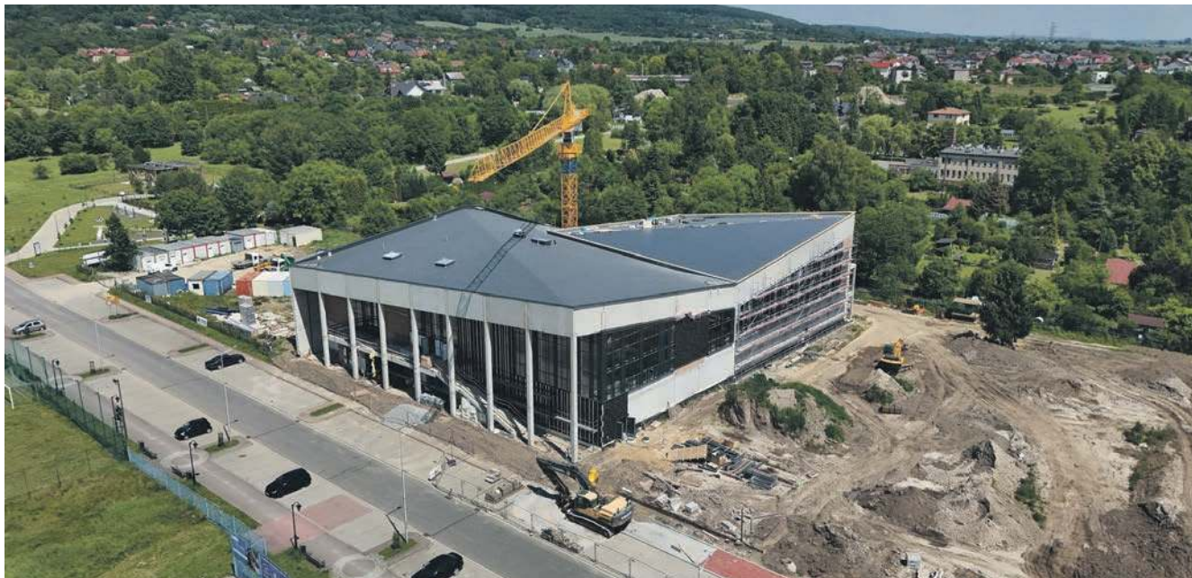
Tak obecnie wygląda powstający w Krzeszowicach basen
