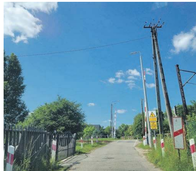
Kwiatowa przy pierwszym przejeździe kolejowym
