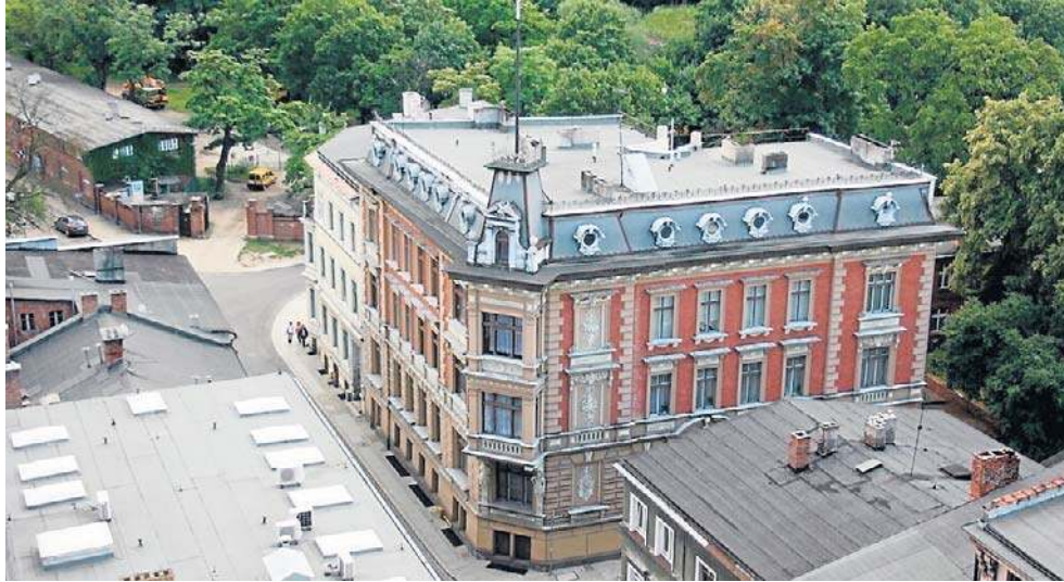
Kamienica Roberta Tilka na rogu ulicy św. Jakuba i Piernikarskiej w Toruniu. W budynku znajdują się imponujące żeliwne schody
