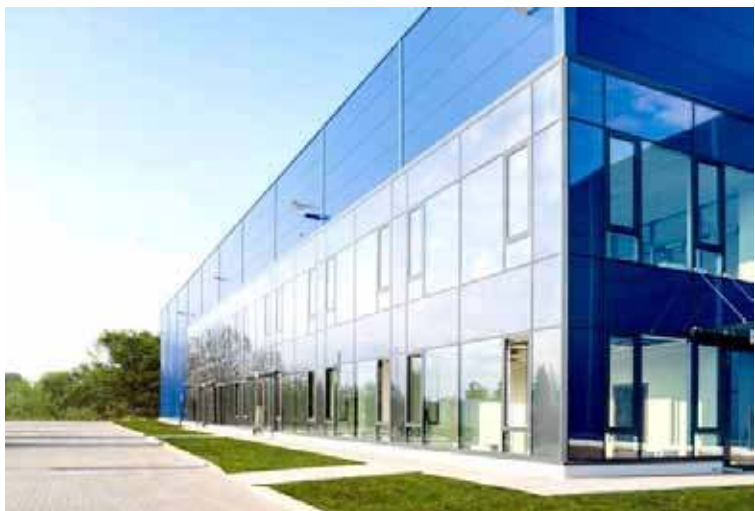
Już wkrótce w Parku Przemysłowym Nowoczesnych Technologii może powstać centrum logistyczne – Panattoni Park Stargard
