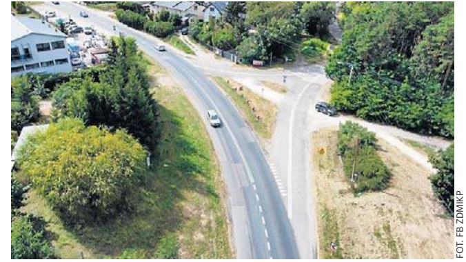
Zakończenie wszystkich prac związanych z przebudową drogi planowane jest jesienią 2026 roku
