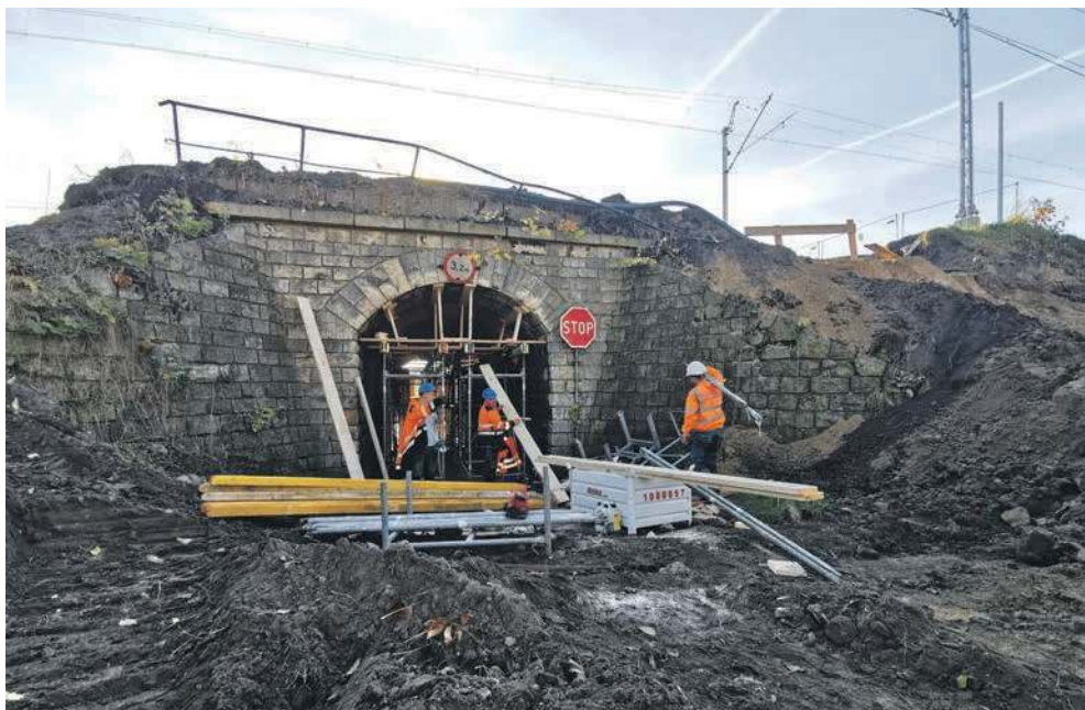
Wiadukt nad ul. Krasickiego
