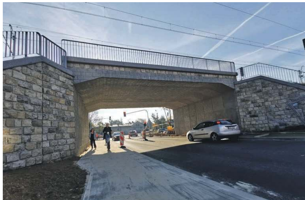
Zmodernizowany wiadukt nad ul. Kadłubek
