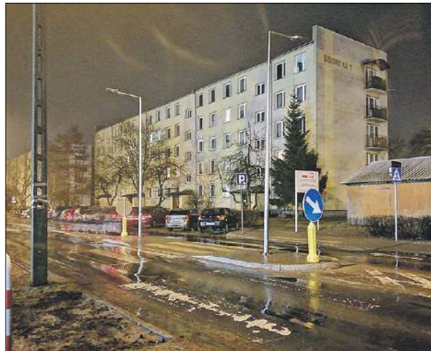
Wybudowane na ul. Sidorskiej przejście dla pieszych do tej pory nie jest oświetlone, bo jak twierdzi PGE, nie może wejść z robotami w pas drogowy
