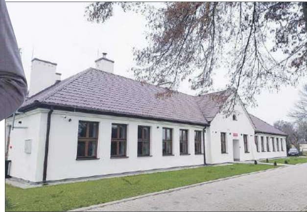
W budynku poszkolnym powstało Centrum Opiekuńczo-Mieszkalne w Dubowie
