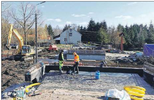
W Rossoszu na ul. Szeleś trwa budowa mostu na rzece Zielawie. Prace idą zgodnie z planem
