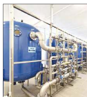
Istotną dla mieszkańców inwestycją była modernizacja hydrofornii
