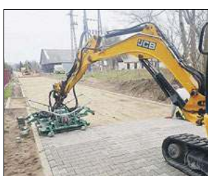
Gmina zbudowała bardzo dużo odcinków dróg gminnych i powiatowych, korzystając z rządowych oraz unijnych dofinansowań. Na zdj. ul. Polna w Sławatyczach
