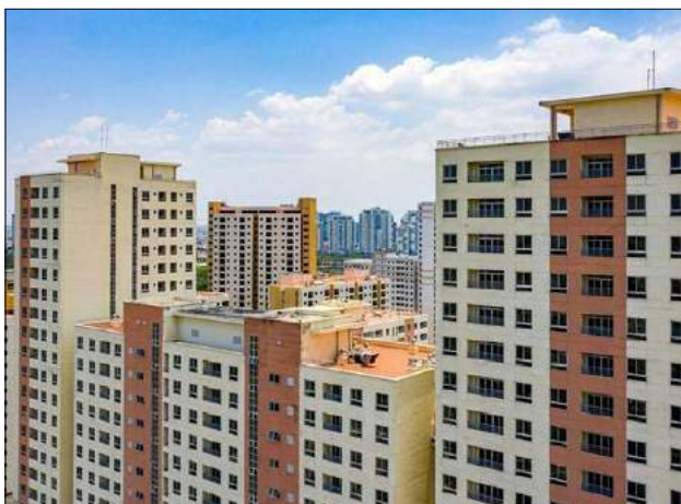
Szacuje się, że w Polsce mamy ok. 60 tys. bloków zbudowanych w technologii wielkopłytowej, w których mieści się ok. 4 mln mieszkańców
