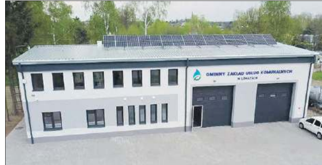
Jedną z kluczowych inwestycji była przebudowa danej bazy kółek rolniczych, gdzie dziś znajduje się GZUK
