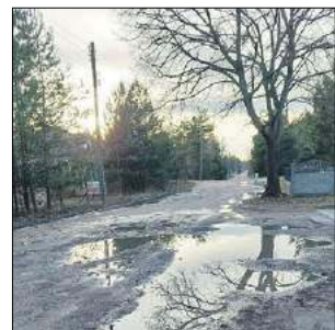
Tak Ceglana wygląda za dnia. Na słupach elektrycznych lamp nie ma, a ulica pełna kałuż
