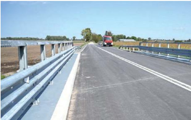
Powiat radzyński słynie z licznych inwestycji drogowych. 25 września br. odbyło się uroczyste otwarcie mostu w Lisiówłce. Całkowity koszt inwestycji opiewał na kwotę ponad 2 mln zł, w tym około 1,5 mln zł to dofinansowanie w ramach Rządowego Funduszu Polski Ład, pozostałe środki pochodzą z budżetu powiatu radzyńskiego
