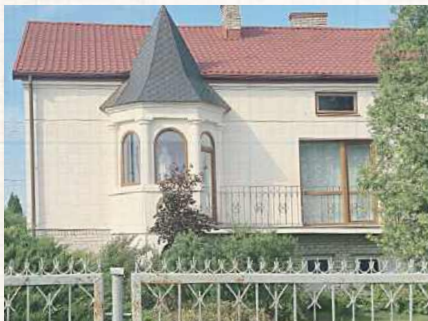
Kaplica domowa Katolickiego Kościoła Mariawitów stoi na końcu wsi, po prawej stronie drogi do Krzyczewa
