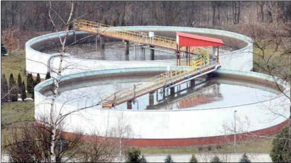
Reaktory rabczańskiej oczyszczalni ścieków,
