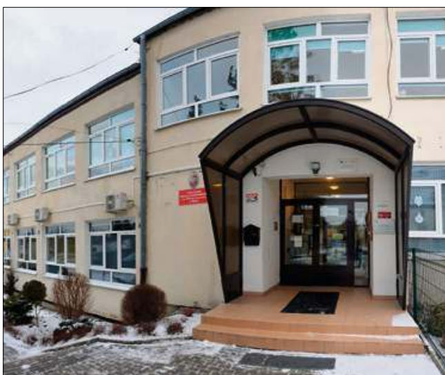
Szkoła i przedszkole zrobiły się już za ciasne, stąd potrzeba rozbudowy.
