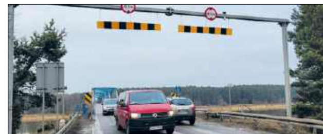
Most ma ponad 70 lat, 295 metrów długości i dziewięć przęseł, a jego konstrukcja nośna nie jest jednolita
