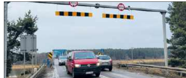
Most ma ponad 70 lat, 295 metrów długości i dziewięć przęseł, a jego konstrukcja nośna nie jest jednolita
