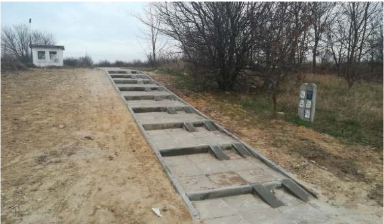
Schody zostały naprawione
