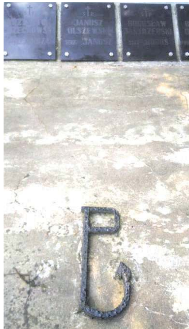
Nazwiska poległych trudno już odczytać, a znak Polski Walczącej jest niekompletny. Miejscu pamięci należy się już porządna renowacja
