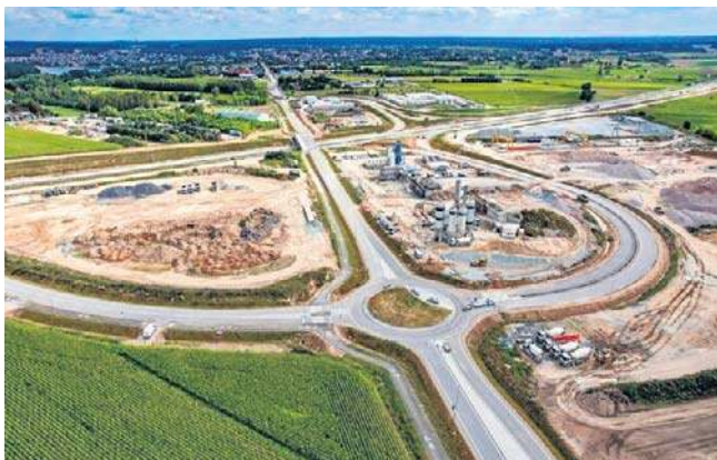
FOT. GDDKiA/STRONA KONTRAKTU
