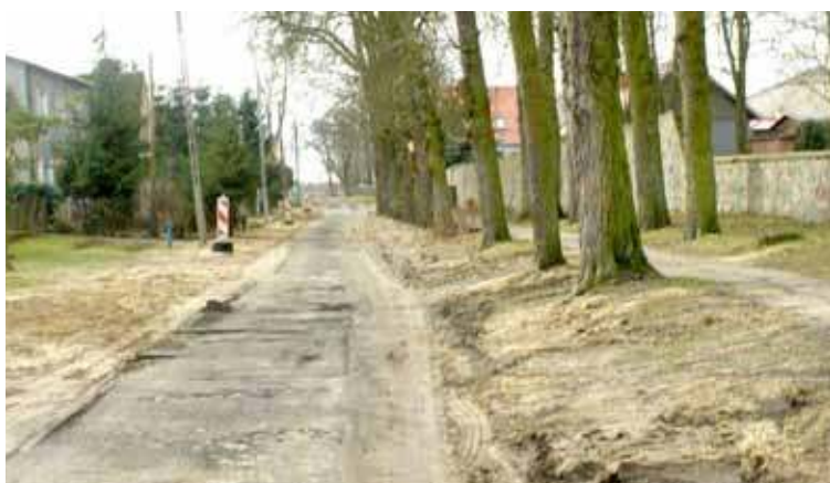
Zakończono prace wstępne związane z wycinką drzew i krzewów kolidujących z przebudowywanym odcinkiem drogi
