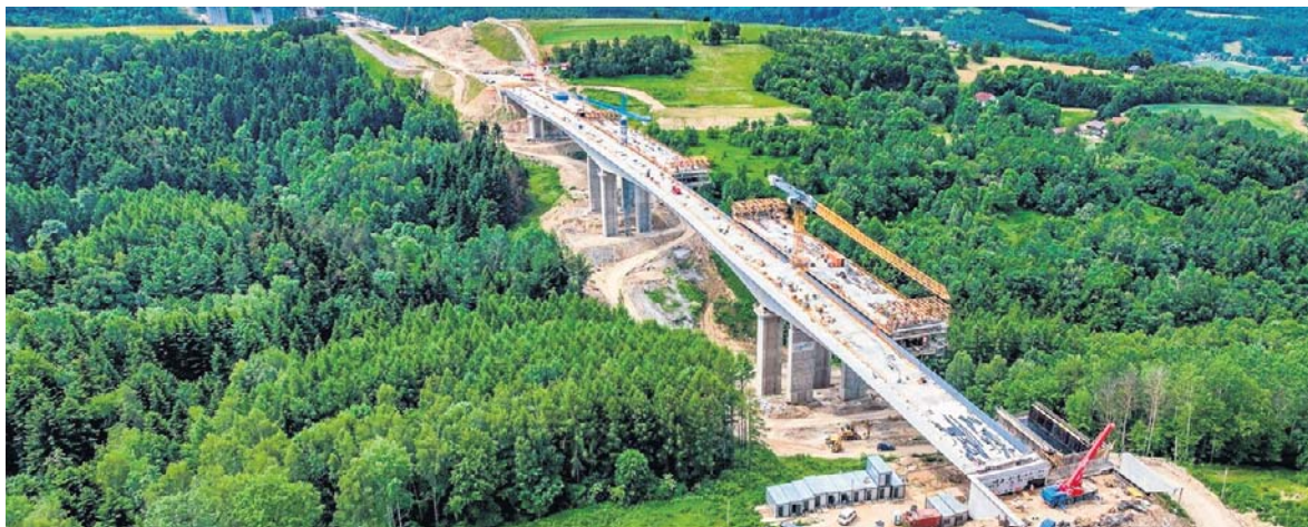
Konstrukcja ma blisko 460 metrów długości i opiera się na pięciu podporach, z których najwyższa sięga 30 metrów wysokości
