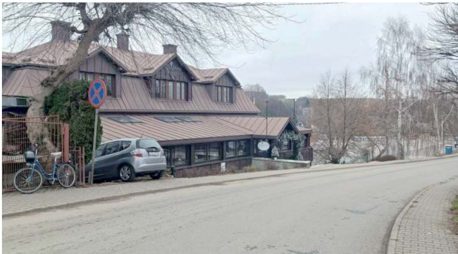
Budynek restauracji i pensjonatu znajduje się tuż przy ulicy 3 Maja. Widać, że targowisko, po którym wiedzie droga dojazdowa do działki z ogrodem za pensjonatem, jest położone dużo niżej
