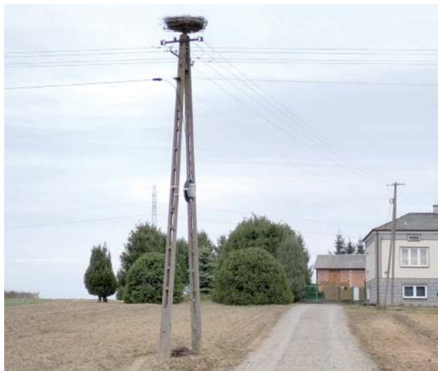
Gniazdo zostało przeniesione na pobliski słup energetyczny
