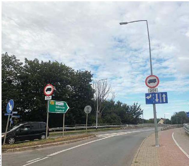
Wprowadzono ograniczenie wjazdu na most Wyszyńskiego dla pojazdów ciężarowych o masie całkowitej powyżej 30 ton
