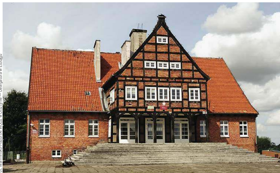
Szkola w Zwiernie (gm. Markusy), dawny Dom Ludowy. Zabytek z lat 30. XX w. zaprojektowany na wzór żuławskich domów podcieniowych doczeka się remontu dachu i wymiany instalacji elektrycznej
