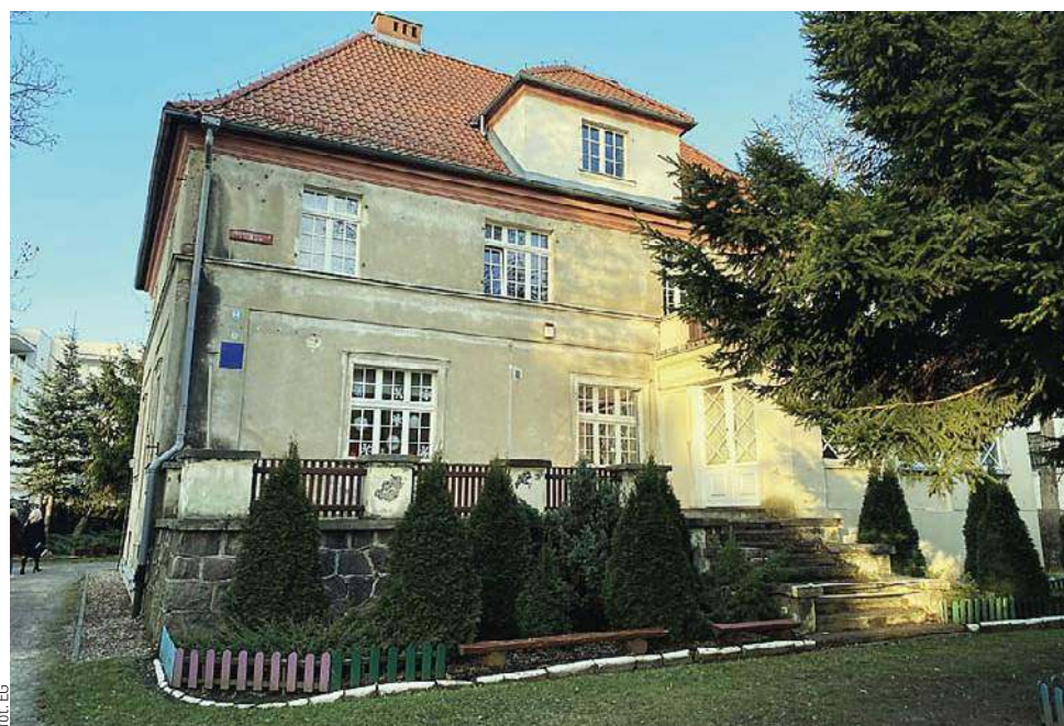
3,430 mln zł — takie dofinansowanie otrzymał Elbląg na remont zabytkowego budynku przedszkola w ramach Rządowego Programu Odbudowy Zabytków
