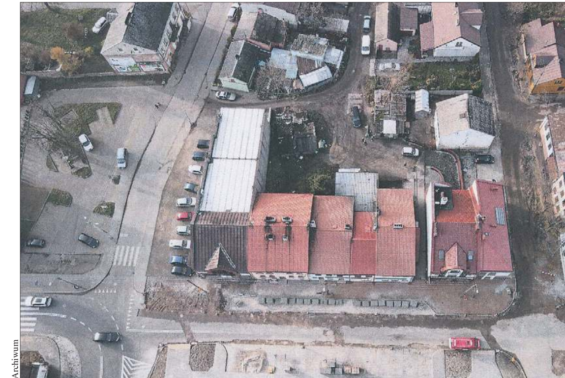
Centrum Drobin z lotu ptaka w trakcie remontu
