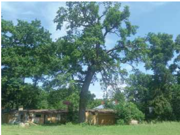
Walorem otoczenia budowli są pomniki przyrody
