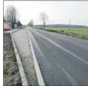
Kierowców czeka czasowe zamknięcie drogi powiatowej nr 1031L na odcinku Klonownica Mała – Ossówka. Szczegółowe mapy objazdów znajdują się na stronie www.janowpodlaski.pl
