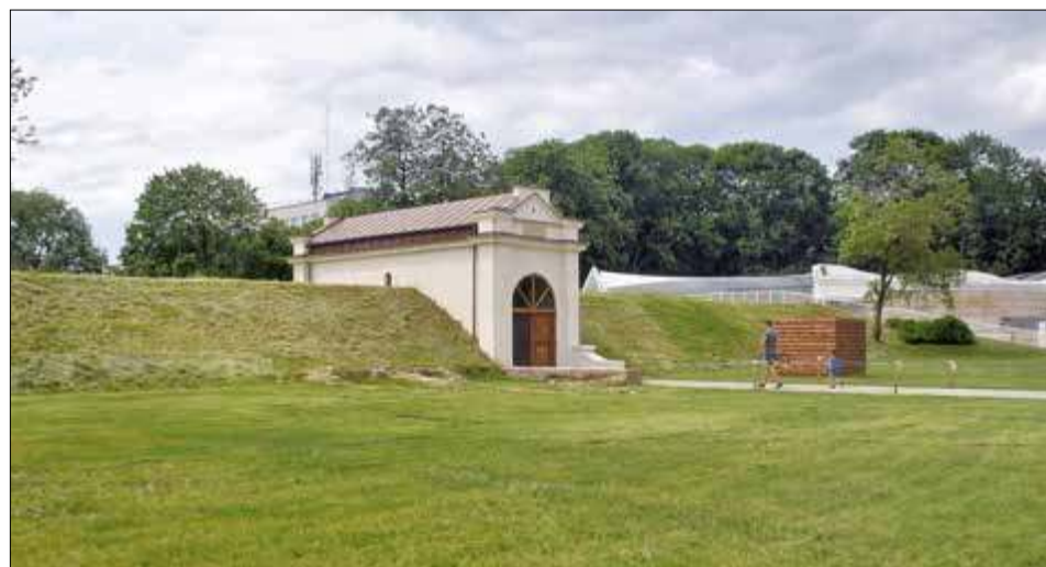
W ramach inwestycji wybudowano bramę i most kozarski od strony zachodniej, odtworzono również fortyfikację
