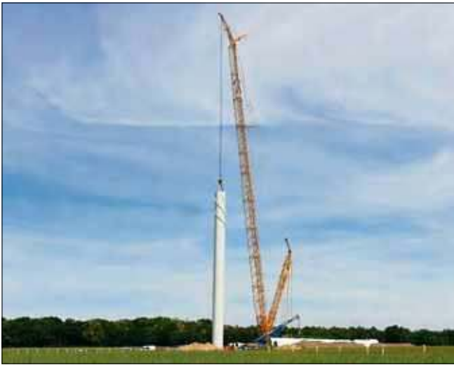
Prace montażowe wciąż trwają.
