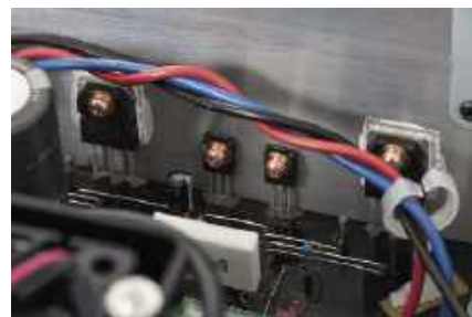
W każdym kanale sekcję wyjściową tworzy para tranzystorów Toshiba zainstalowana na dużym radiatorze.
