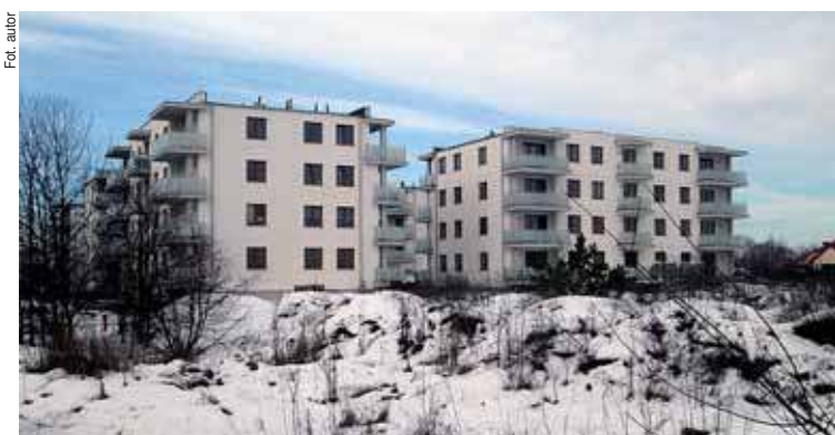
Mława jest wielkim placem budowy
