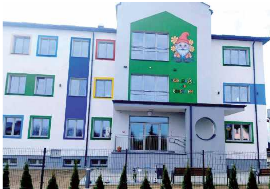
Tak wygląda budynek po remoncie
