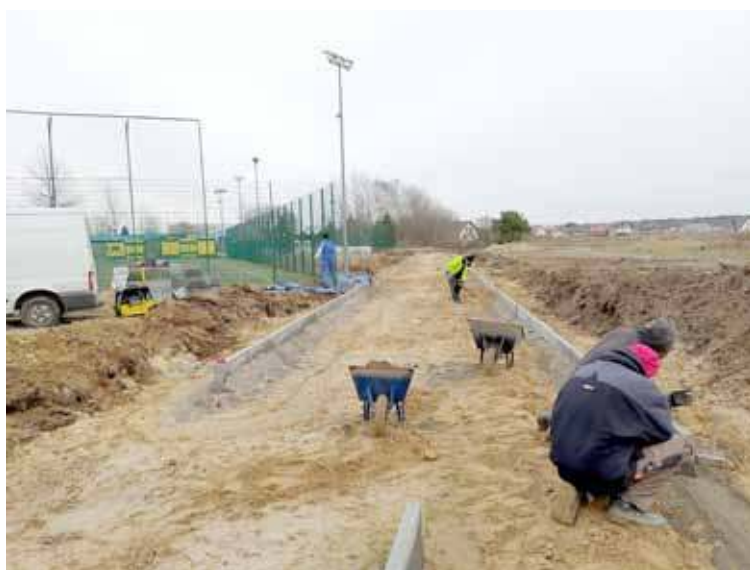
Prace postępują w bardzo szybkim tempie, biorąc pod uwagę niekorzystne warunki w początkowej fazie inwestycji
