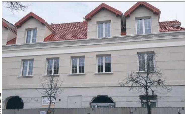
Nowa siedziba Działu Zbiorów Audiowizualnych Książnicy Płockiej będzie gotowa do użytku w czerwcu przyszłego roku
