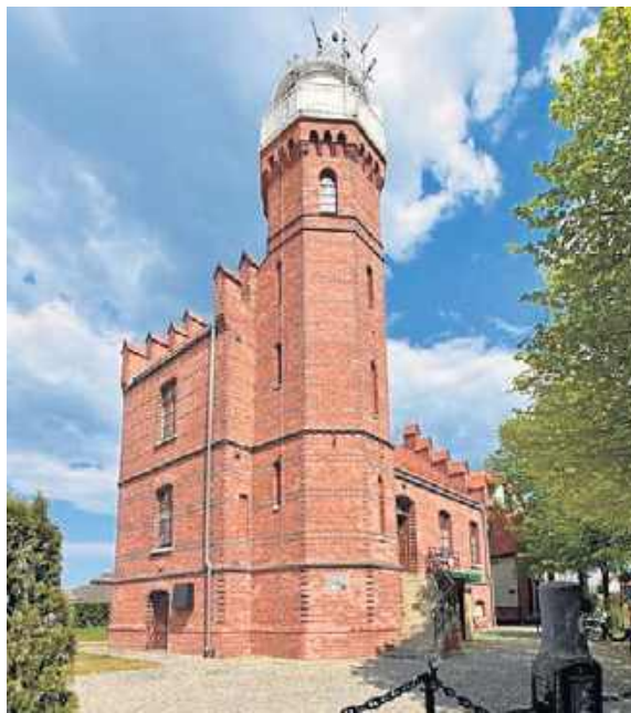
Ceglana latarnia w Ustce
