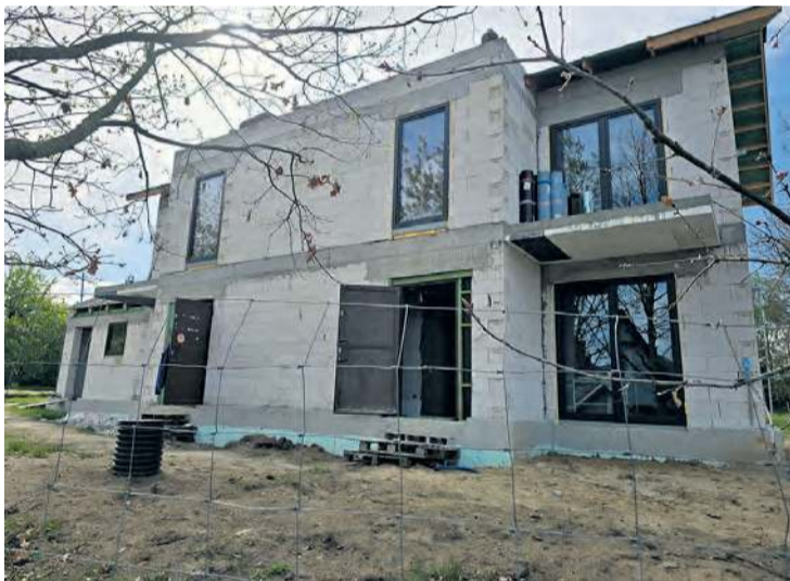
Wejścia do mieszkań usytuowane są od ulicy Starowiejskiej.
